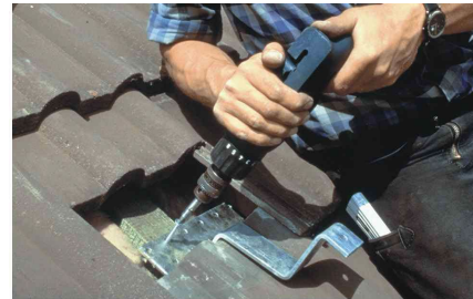
Mise en place des pattes de fixation
