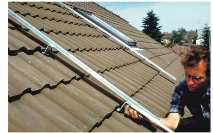
Installation des rails de fixation
